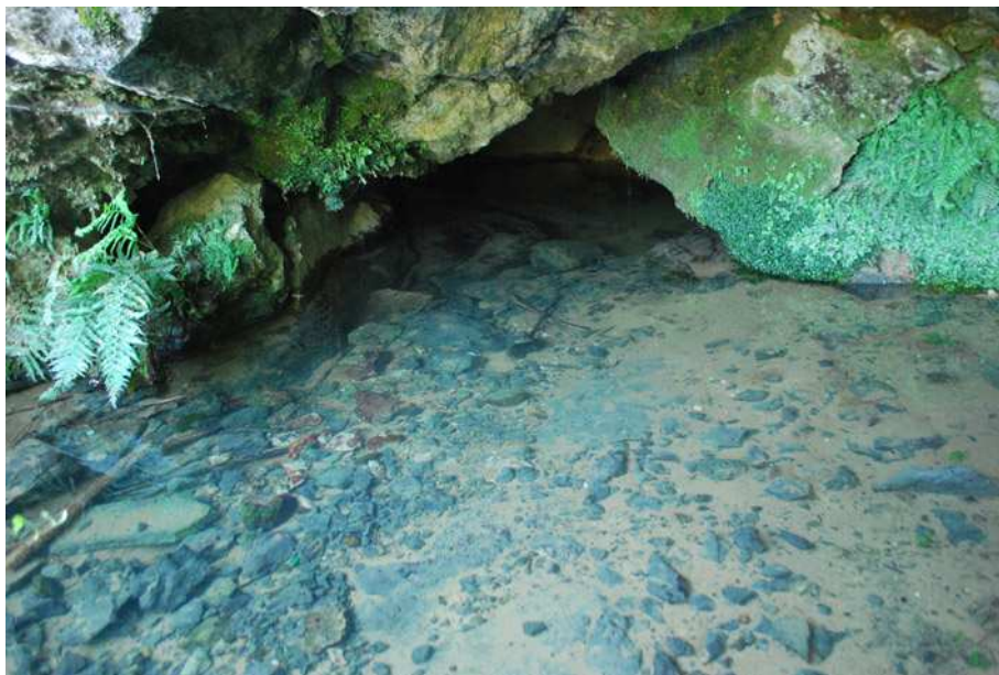
Acceso a la galería
